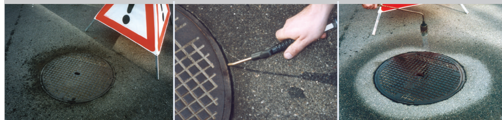
Lose Teile werden gründlich entfernt
